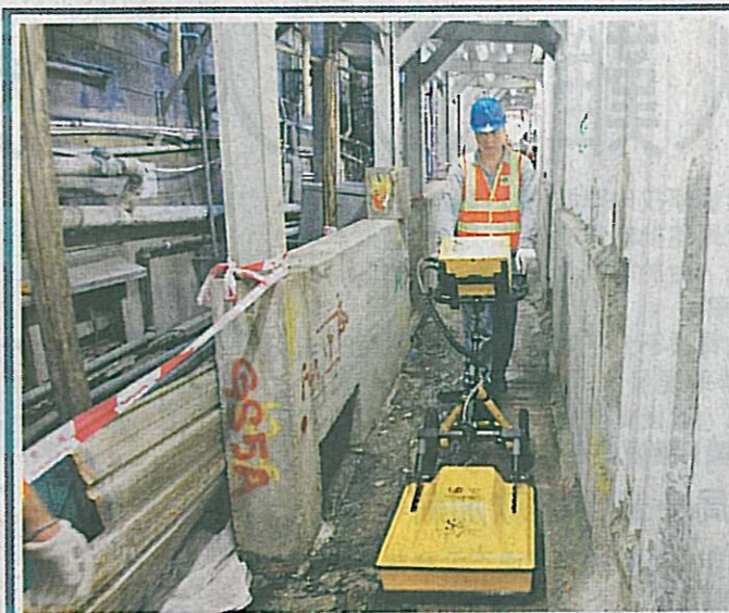
益捷探測工程公司人員在德忌利士巷，用 地底雷達探測地下空洞狀況，初步認為只有一 處的泥層密度稍低，其他地方無空洞和水管漏 水問題。 (梁偉榮攝)
